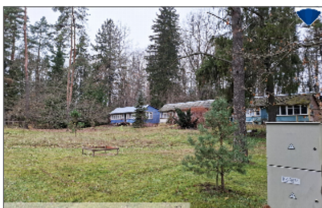
KAMUOLINĖ ŠVIŠKĖ VILŲ ELEKTROS DĖŽĖ
