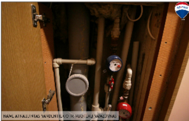
NAMLAI NAUJINTAS VANDENTILKO IR RUDU DUJ VAMZDYNAS
