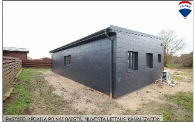
PASTATO APDAILA PILNAI BAIGTA, NUVESTA LIETAUS KANALIZACIJA
