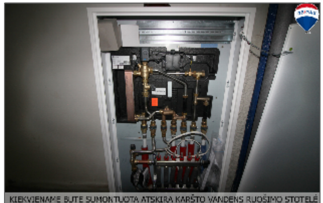
KIEKVIENAMŲ BUTŲ SUMONTUOTA ATSKIRA KARŠTO VANDENS RUOŠIMO STOTELĖ
