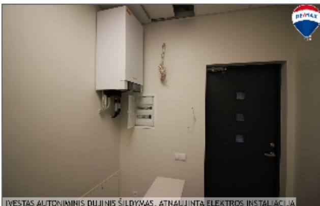
ĮVESTAS AUTONIMINIS DUJINIS ŠILDYMAS, ATNAUJINTA ELEKTROS INSTALIJAIJA
