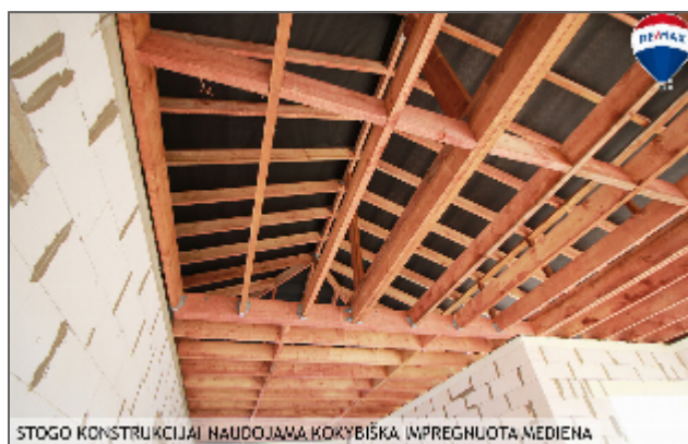
STOGO KONSTRUKCIJAI HAUDOJAMA KOKYBIŠKA ĮPREGHUOTA MEDiena
